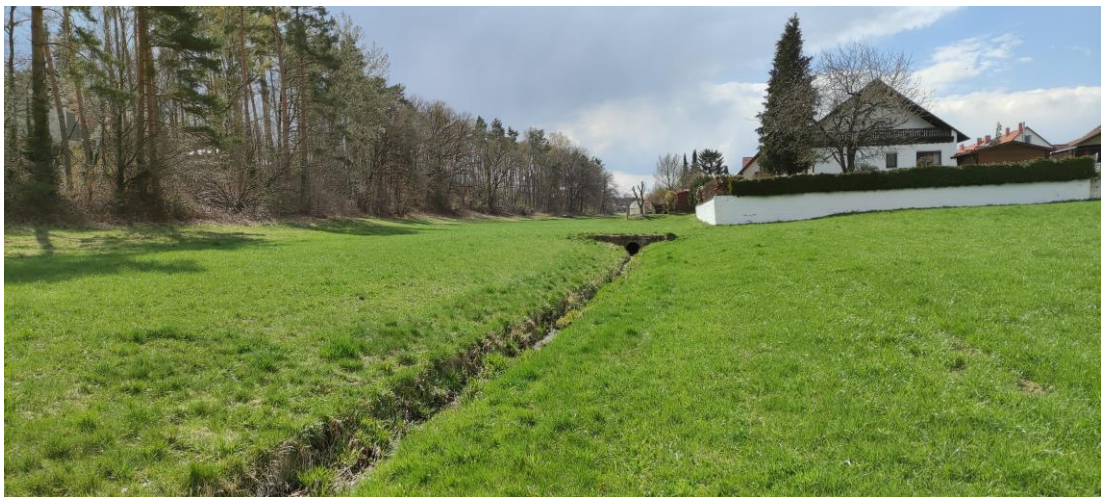
Abbildung 5: offener Abschnitt Jordangraben im Hintergrund der verrohrte Übergang zwischen den beiden Baugebiete Am Jordan und Kiefernweg
