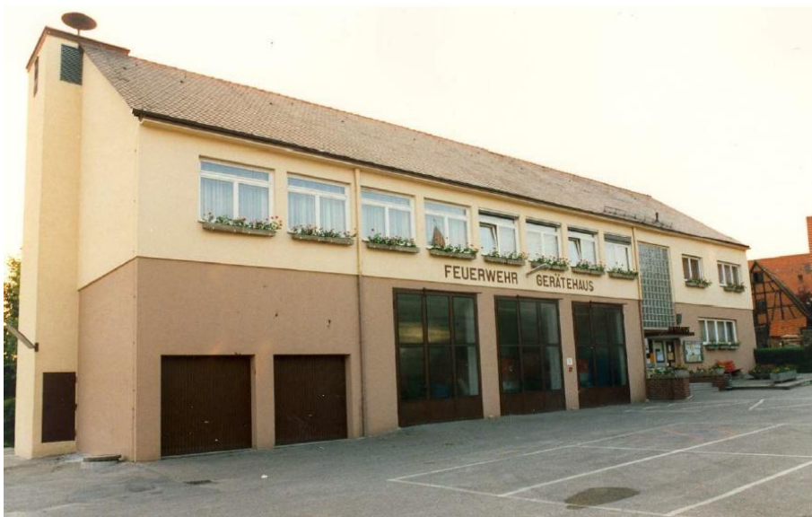
Ortsmitte vor der Altortsanierung (Feuerwehrhaus)
