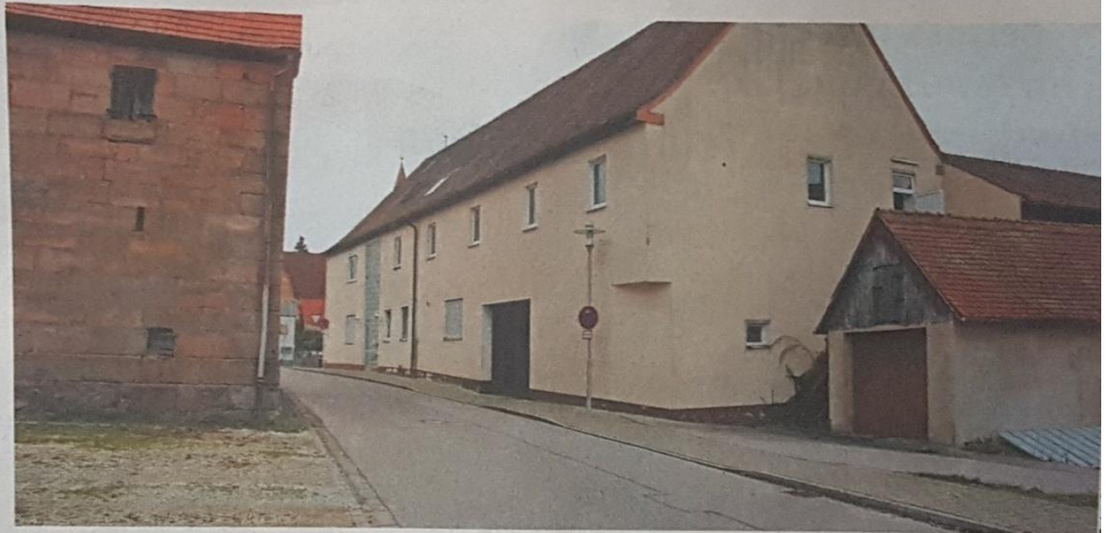
Derzeit weder von vorne noch von hinten eine Augenweide: Das ehemalige Anwesen Glauber und der Bereich am Kirchensteig direkt dahinter bieten Raum und Anlass für städtebauliche Verbesserungen.
