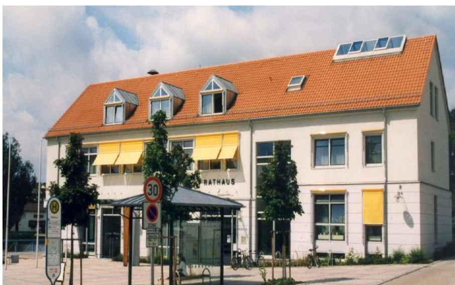
Ortsmitte nach der Altortsanierung 2004 (Rathaus)
